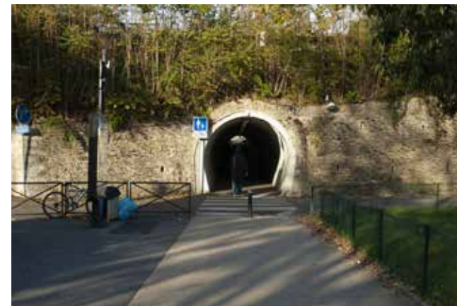
Vue accès SUD du passage piétonnier
