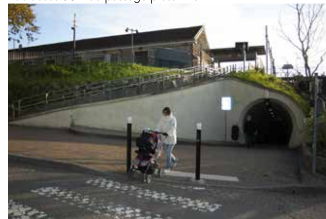
Vue accès NORD du passage piétonnier
