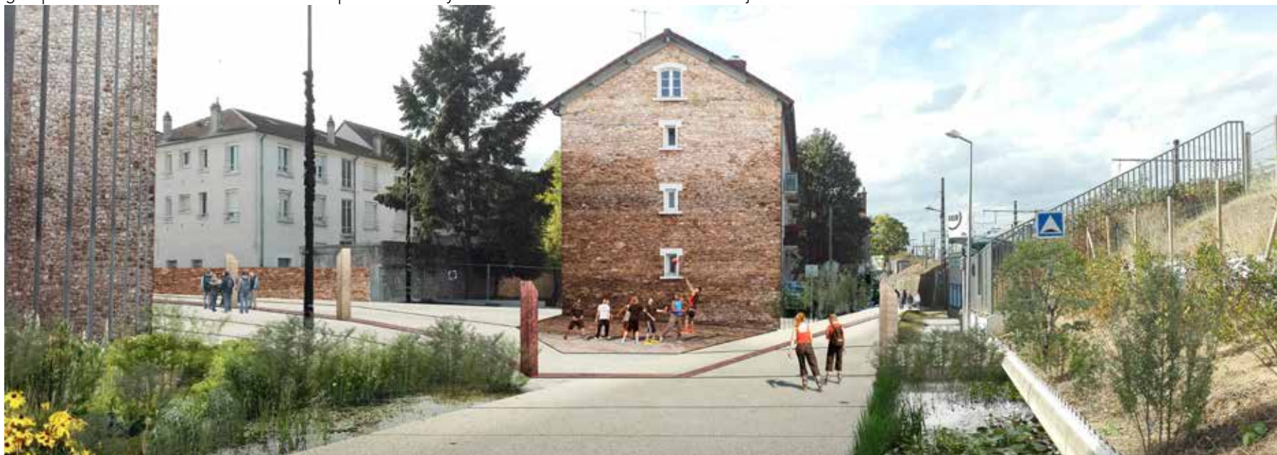
La place de la Terre, nouveau parvis mêlant activités sportives, lieu de passage et de détente. Les totems de terre crue servent de régulateurs climatiques.
